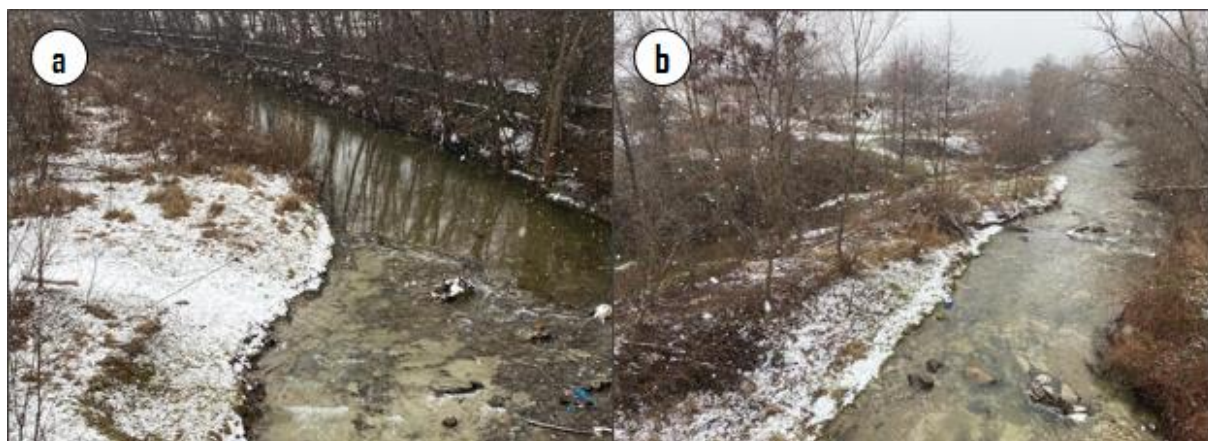
Fig. 19. Valea Borodului în amonte (a) și în aval (b) de podul de peste DN1 din satul Gheghie (fotografii realizate de pe pod de către Popa Rareș George)
